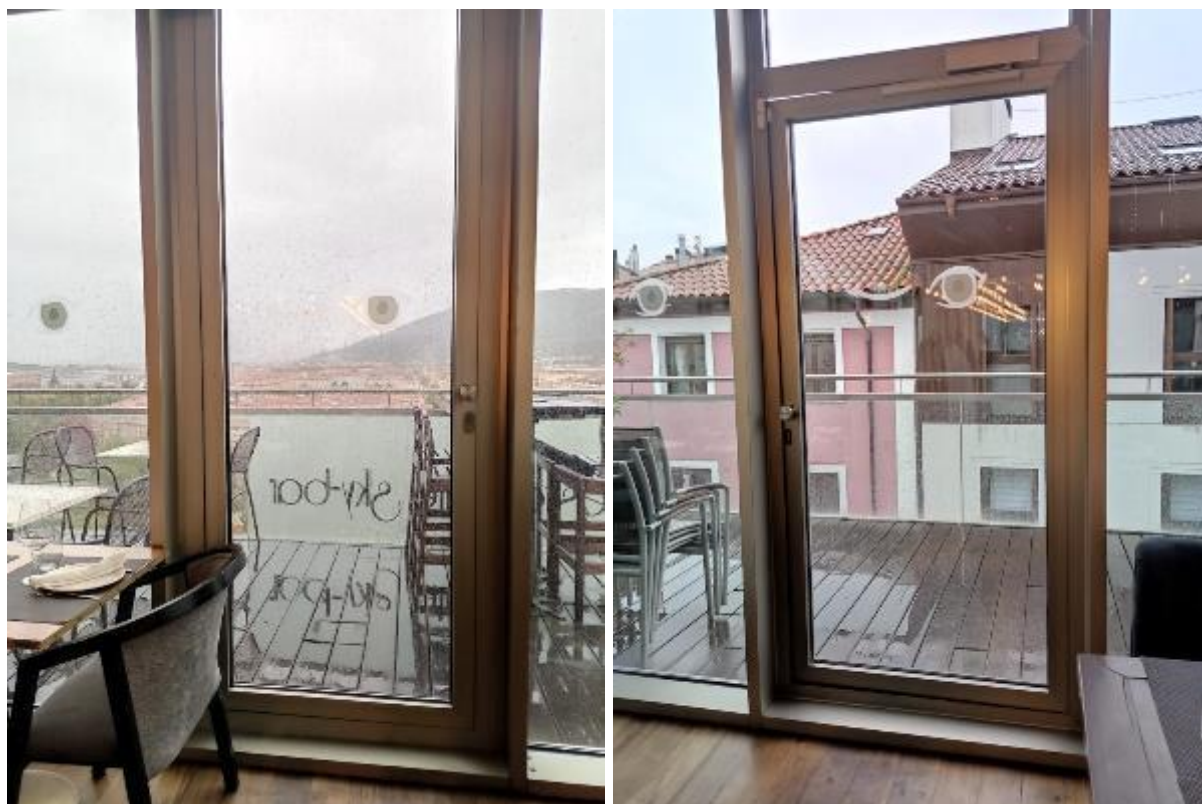
Salidas a las terrazas (no accesibles) en el Restaurante El Búho. Fuente: propia
