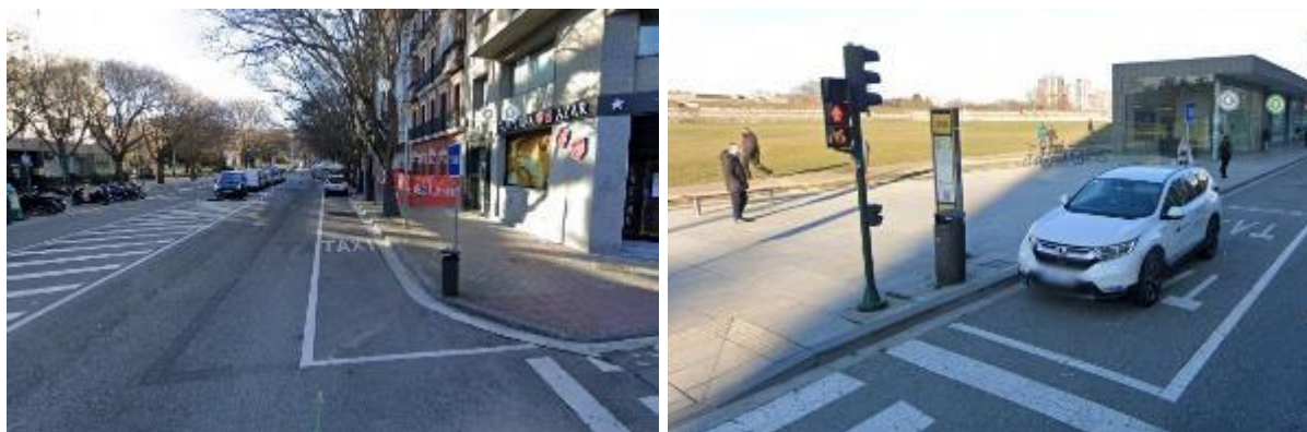
Parada Navas de Tolosa (rebaje en paso situado en esquina contigua) y Parada Estación de Autobuses (rebaje en paso posterior, poste informativo)
