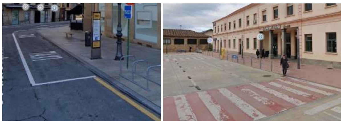
Parada Duque de Ahumada (sin rebaje) y estación de tren, con acera a nivel
